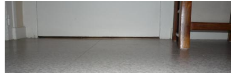
Détalonner les portes
